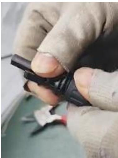
7) 将制作好的正负对接器与板子上的总正（负）对接器进行对接
