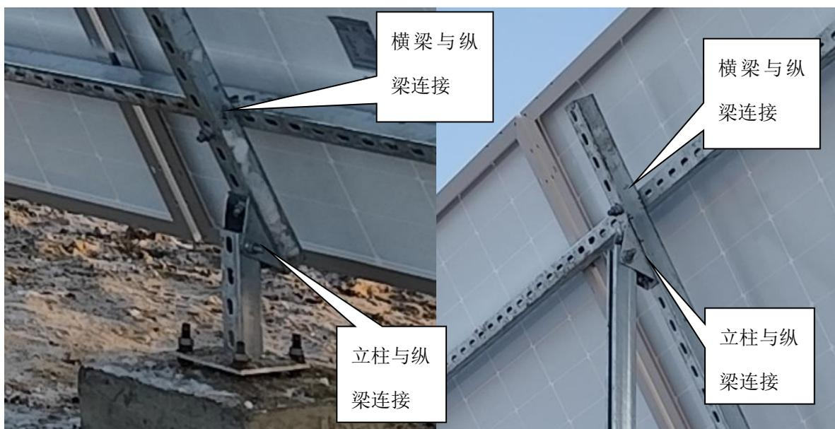
图 2-3 前后立柱与纵梁连接、纵梁与横梁连接
