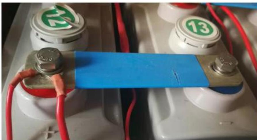
图 4-8 内阻、电压采集线安装方法
