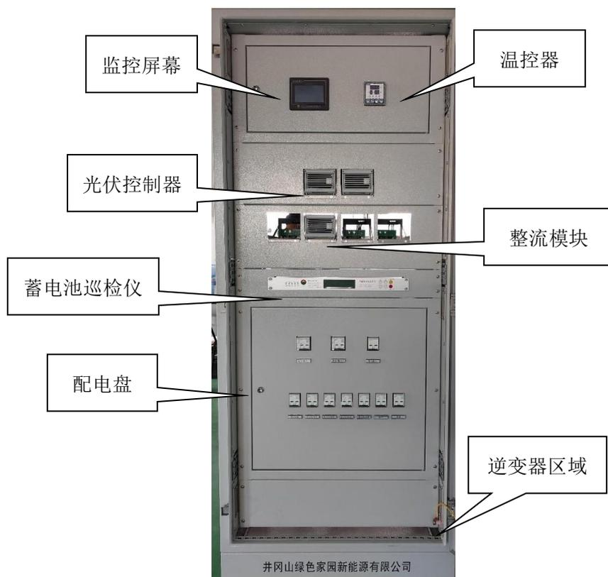
图 4-2 控制柜正面构造图
